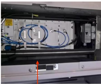
zona di installazione su treni NTV
